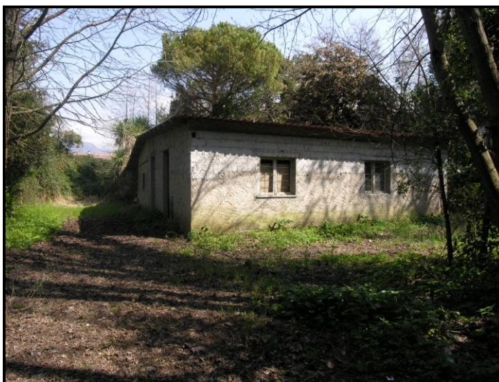
Immobile oggi esistente all'interno della proprietà Galeotti per il quale pende ricorso al T.A.R. previsto in demolizione
