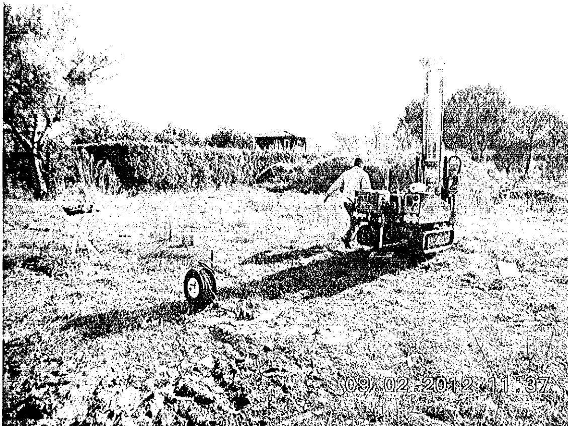
Figura 1. Indagine sismica Downhole. 11m
