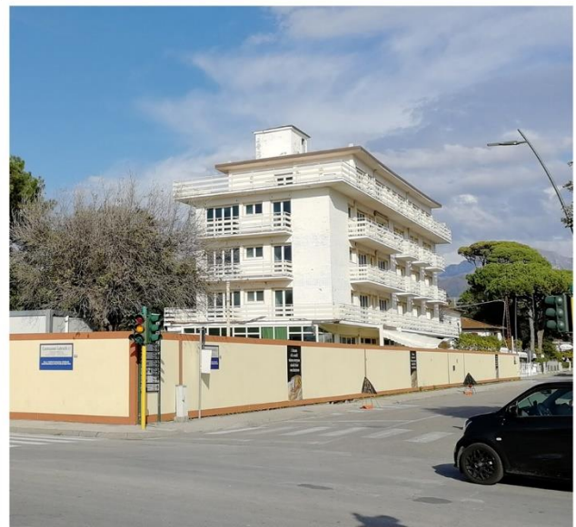
Foto area di intervento
